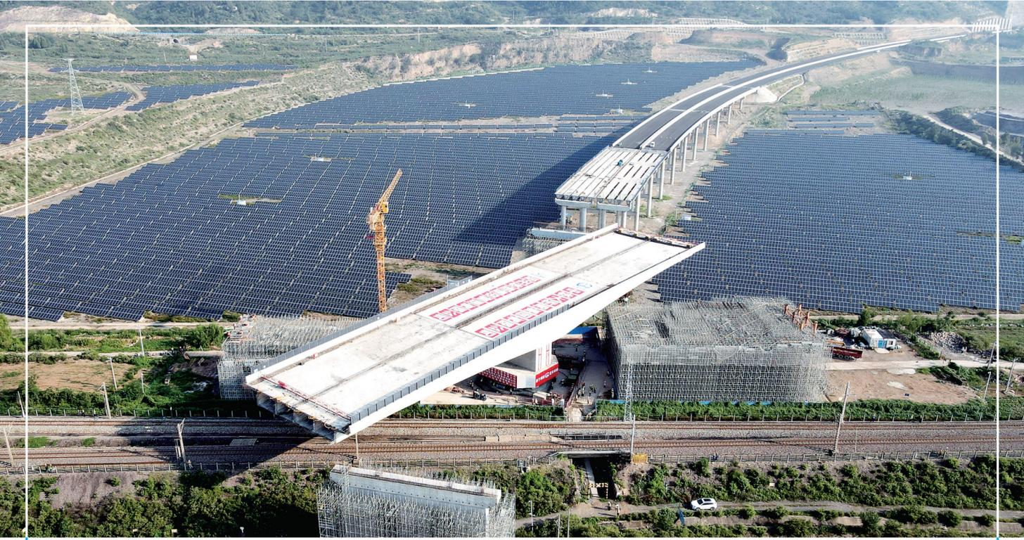
8月11日，由中铁大桥局承建的河南省济源市沿太行山高速公路上跨焦(作)柳(州)铁路立交桥成功转体。转体主梁总长130米，总重量达2.1万吨。图为施工现场。（新华社记者 朱祥 摄）
