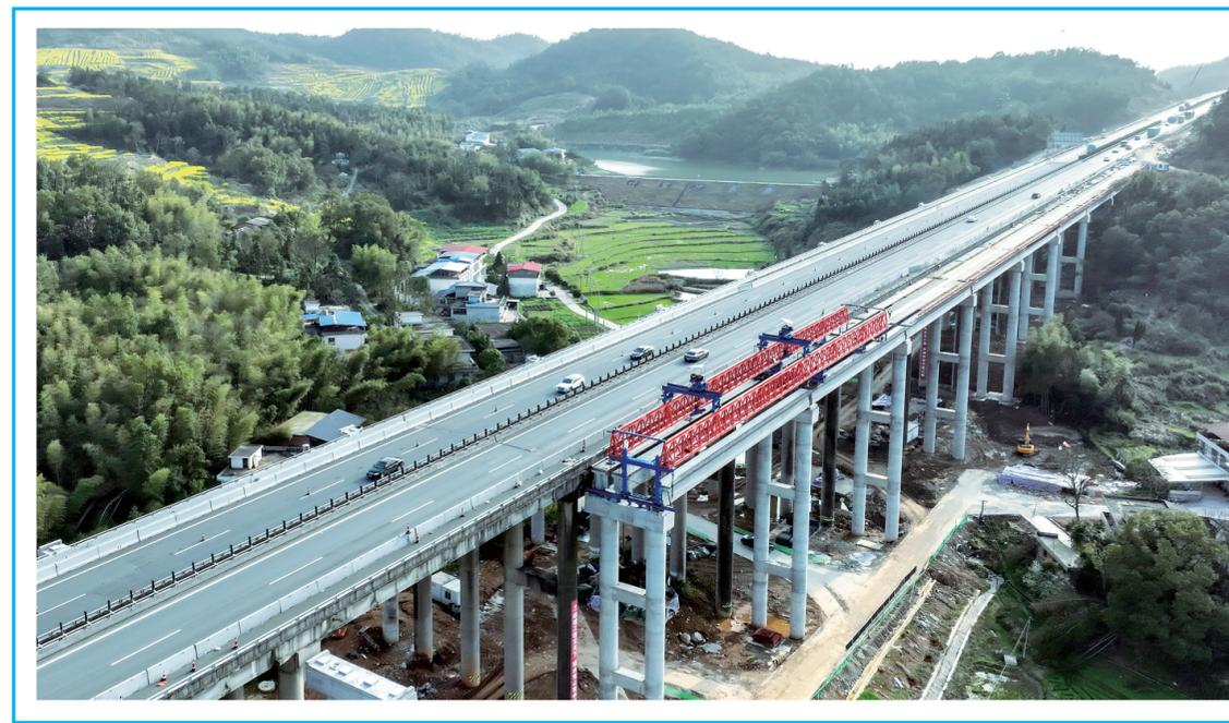
日前,工人正在沪昆高速安源区青山镇段进行改扩建施工。沪昆高速昌昌段改扩建工程项目起点位于樟树市昌傅镇,途经宜春、新余、萍乡3个设市区的11个县区、36个乡镇,终点位于湘赣省界处金盆石。该项目除了新建的复线路段采用双向六车道标准外,其余利用既有高速公路改扩建的路段采用双向八车道标准,项目建成后,江西省大“十字型”八车道高速公路骨架将全面形成,将进一步提高沿线群众的出行质量,助推江西高质量发展和湘赣边区域合作示范区建设。(记者 李桂东 摄)
