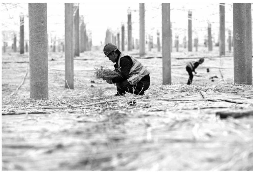
4月26日,工人在亿利库布其沙漠光伏治沙基地种植苗木。近日,在内蒙古自治区杭锦旗亿利库布其沙漠光伏治沙基地,工人们忙着在光伏架下种植耐旱苗木,用于防风固沙。目前,亿利库布其沙漠光伏治沙基地正在建设中,此次规划种植面积上万亩。
